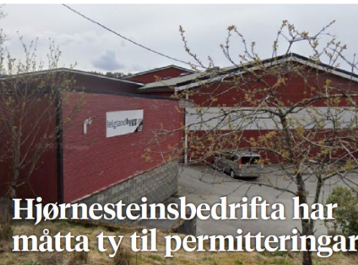
STRANDVIK: Leifland Bygg AS har hovedkontor i Strøndal og har lag i 50 tilsette
