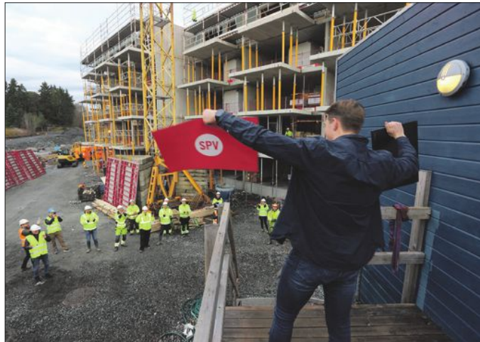
HYLLET: Da Henrik Wisth kom ut på byggeplassen etter å ha blitt kåret til årets lærling, ble han hyllet og gratulert av alle kollegene på anleggsplassen på Sandslimarka.
