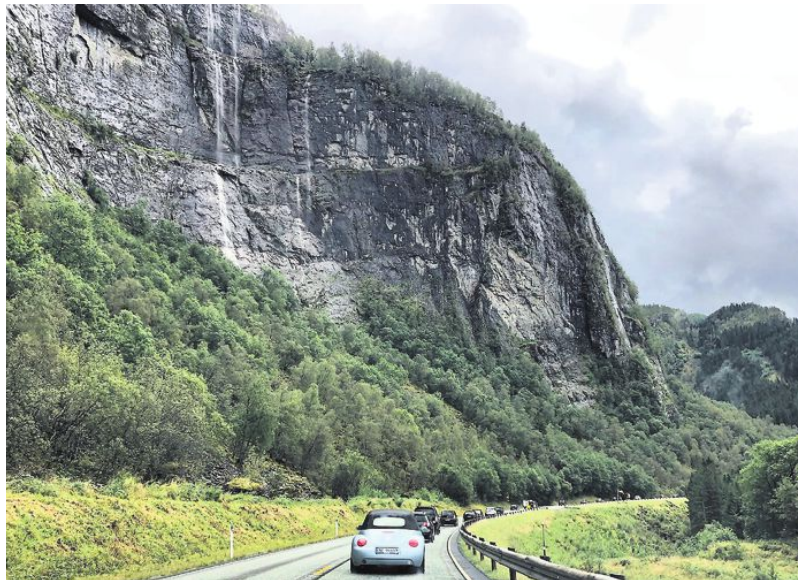
VIKTIG I VEST: Utbedring av den farlige og ulykkesutsatte E 16 mellom Voss og Bergen er ett av flere veiprojekter som Vestland fylkeskommune må stå på for å få gjennomført. FOTO: BA ARKIV
