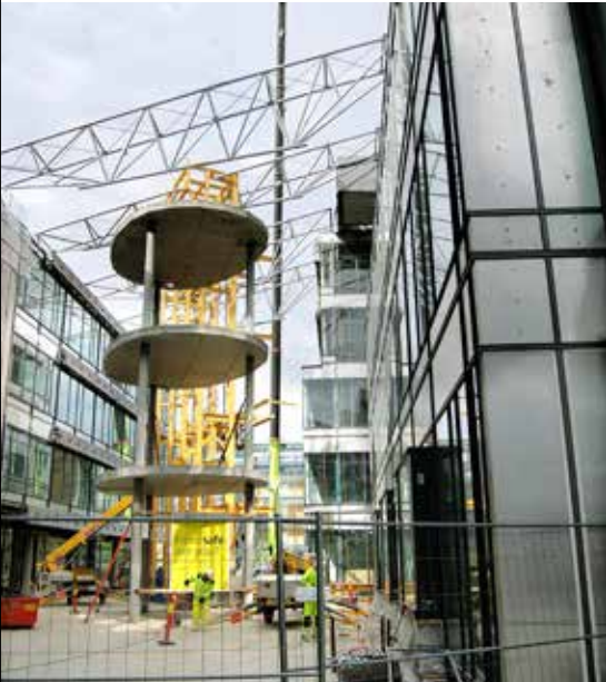
Den eksisterende og den nye kontordelen til Statoil skal bindes sammen med et gigantisk glasstak.
