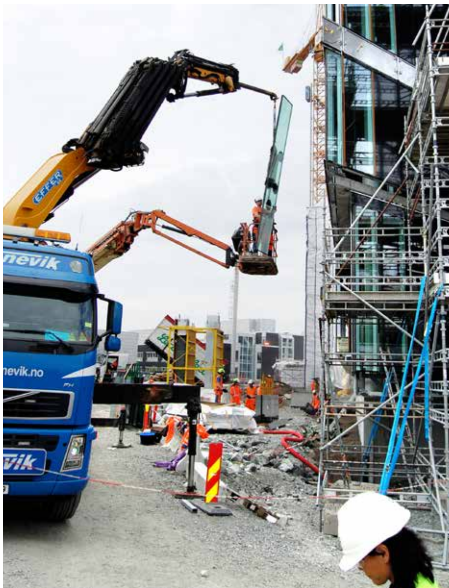
Skanska Tsjekkia har produsert alle fasader til nybygget til Statoil. Her blir en glassfasade heist opp og skrudd på plass.
