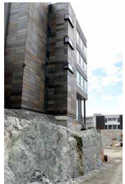
Utsprengning er foretatt bare 2,5 meter fra den eksisterende bebyggelsen på tomten.
