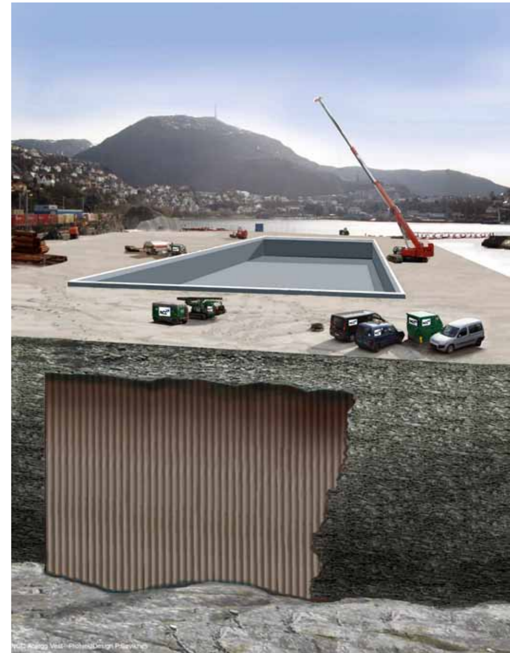
NCC utfører grunnarbeidet på nytt hovedanlegg for svømming og stup samt Amalie Skram videregående skole. Til bassenget har det gått med nesten 17.000 kubikk betong og høyden fra topp til bunn er 32 meter på det meste.
