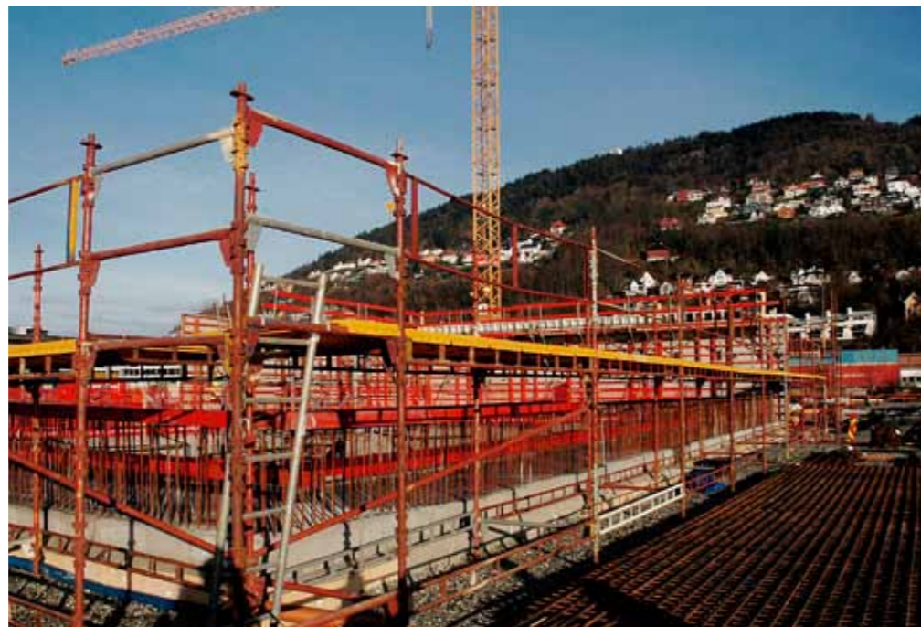
Det går med 2.175 tonn armering til byggingen av Helleren; det nye riksanlegget for stup og svømming og Amalie Skram videregående skole.
