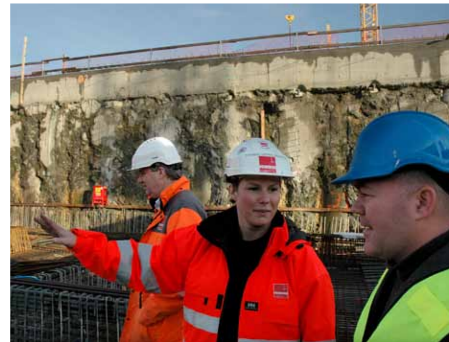
Prosjektleder Therese Urdahl Bratseth orienterer direktør Hans Martin Moxnes i EBA Vestenfjelse (t.h) om arbeidet på anlegget. Bak står distriktssjef Lars Rune Folkedal i Veidekke Entreprenør.
